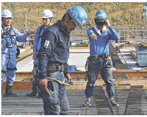
MRで鉄筋組立完了後の配筋チェック(右端の男性がレンズを装着して鉄筋位置をみる)
